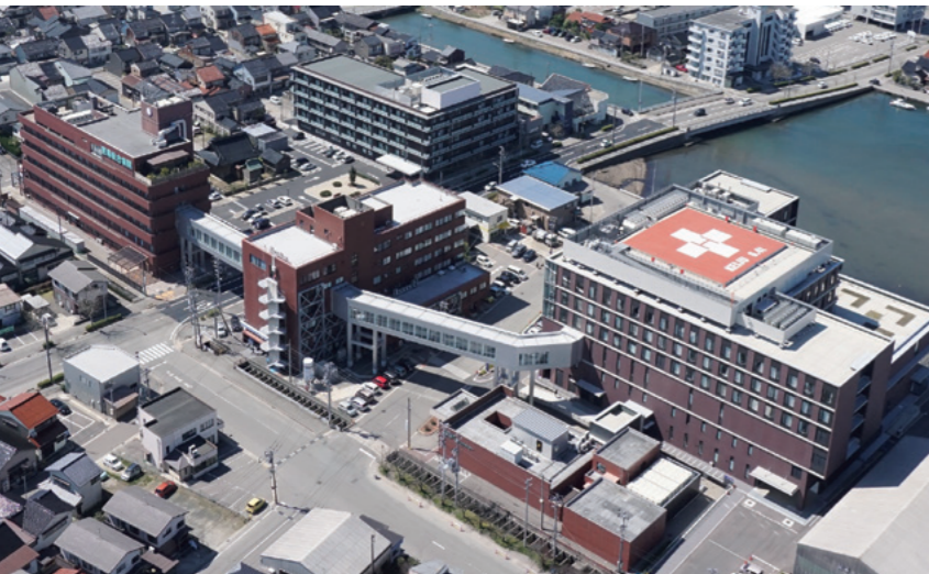
恵寿総合病院。無傷だった本館(右)と上空連絡通路で結ばれた3病棟(中央手前)、その左は同じく上空連絡通路でつながる5病棟。奥の建物は血液浄化センター
